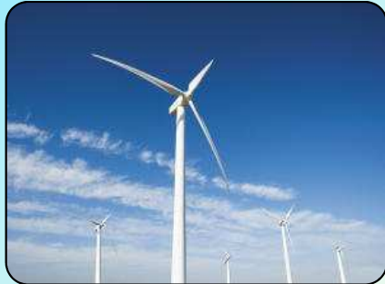
風力発電設備
