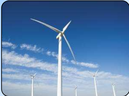
風力発電設備
